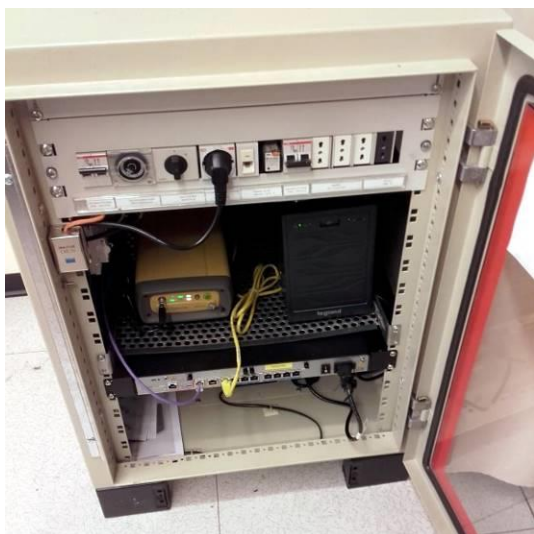
Armadio contenente il ricevitore, il router ed il gruppo UPS
